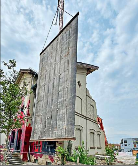
Eine große Abdeckung schützt den Stadtgraben beim Abriss.
