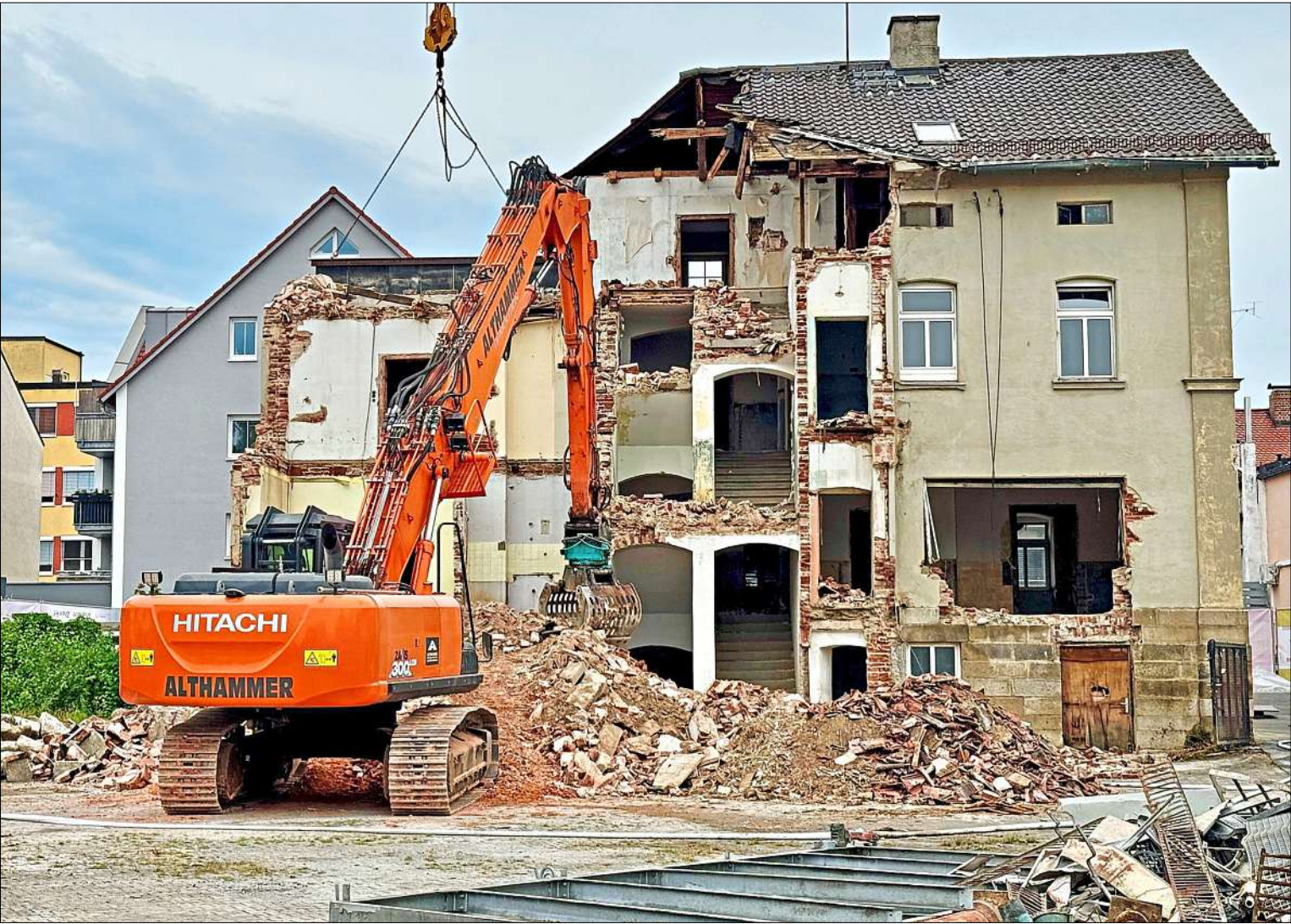
Seit Montag wird das Leiß-Haus im Westlichen Stadtgraben abgerissen. Penzkofer wird am Herbst ein neues Gebäude mit 37 Wohnungen bauen und mit einem Immobilienbüro selbst in eine Gewerbeeinheit im Erdgeschoss einziehen. – Fotos: Sußbauer
