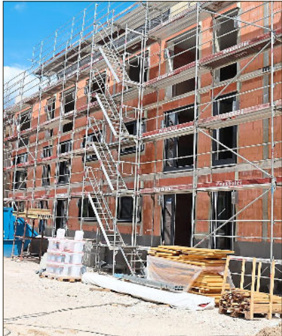
Baufeld 2 befindet sich noch im Rohbau.
