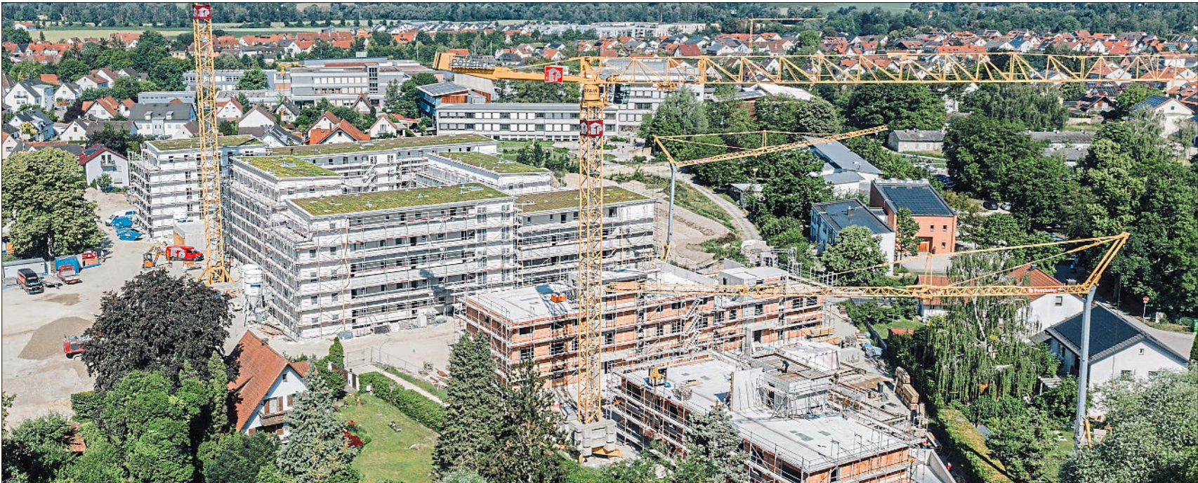
Auf den 96 Wohnungen des geförderten Wohnungsbaus ist bereits die Dachbegrünung zu sehen.
