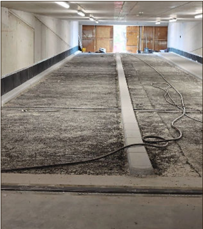
An der Ausfahrt der Tiefgarage wird noch gewerkelt.
