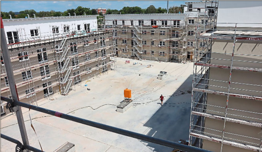
Die vier Gebäude haben einen Innenhof, der als Begegnungsstätte genutzt werden soll. Der Innenausbau hat bereits begonnen.
