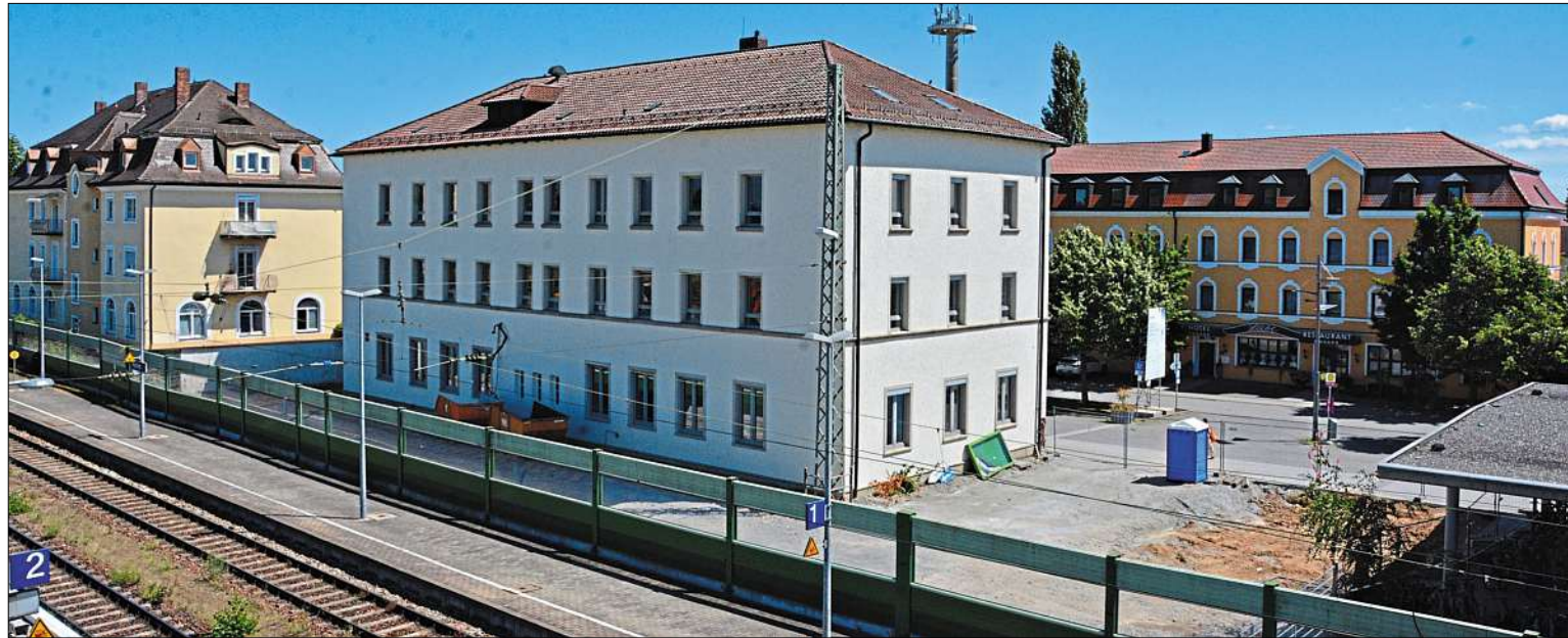
Fünf Stockwerke und über 2000 Quadratmeter Nutzfläche soll das Postgebäude am Bahnhofplatz nach dem Umbau umfassen. Der Freistaat bleibt lediglich Mieter.
