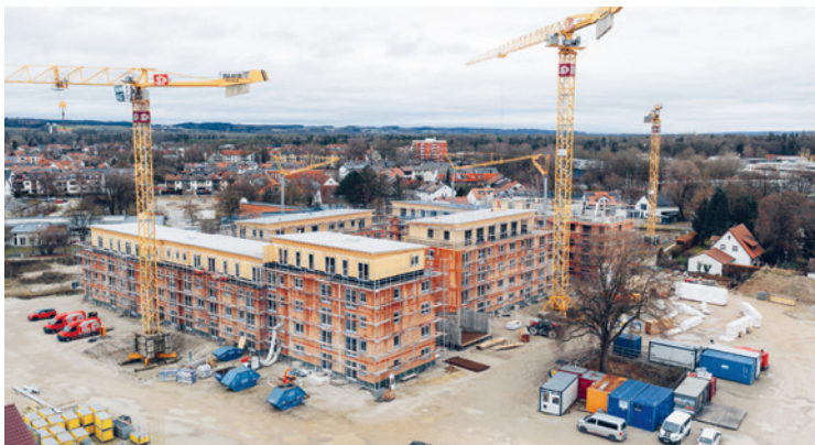
Aktueller Blick auf die Baustelle in Moosburg: Die Arbeiten schreiten sichtbar voran und markieren den nächsten Schritt auf dem Weg zum neuen, modernen Wohnquartier
