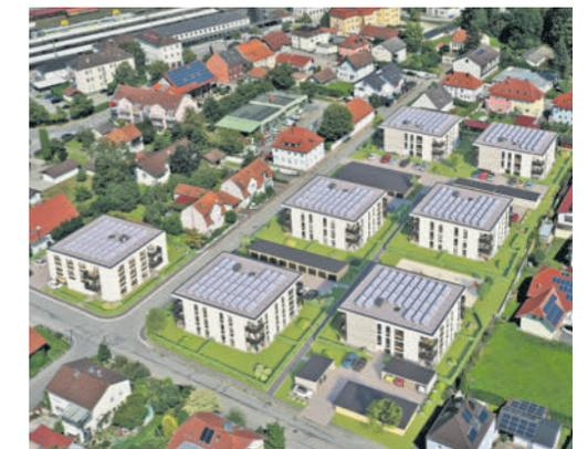
**Neue Wege in der Baubranche:** Das „Goldsteig Quartier“ in Plattling wird komplett in Holzmassivbauweise gebaut, mit leimfrei verbundenen Massivholzwänden und -decken aus eigener Fertigung.
