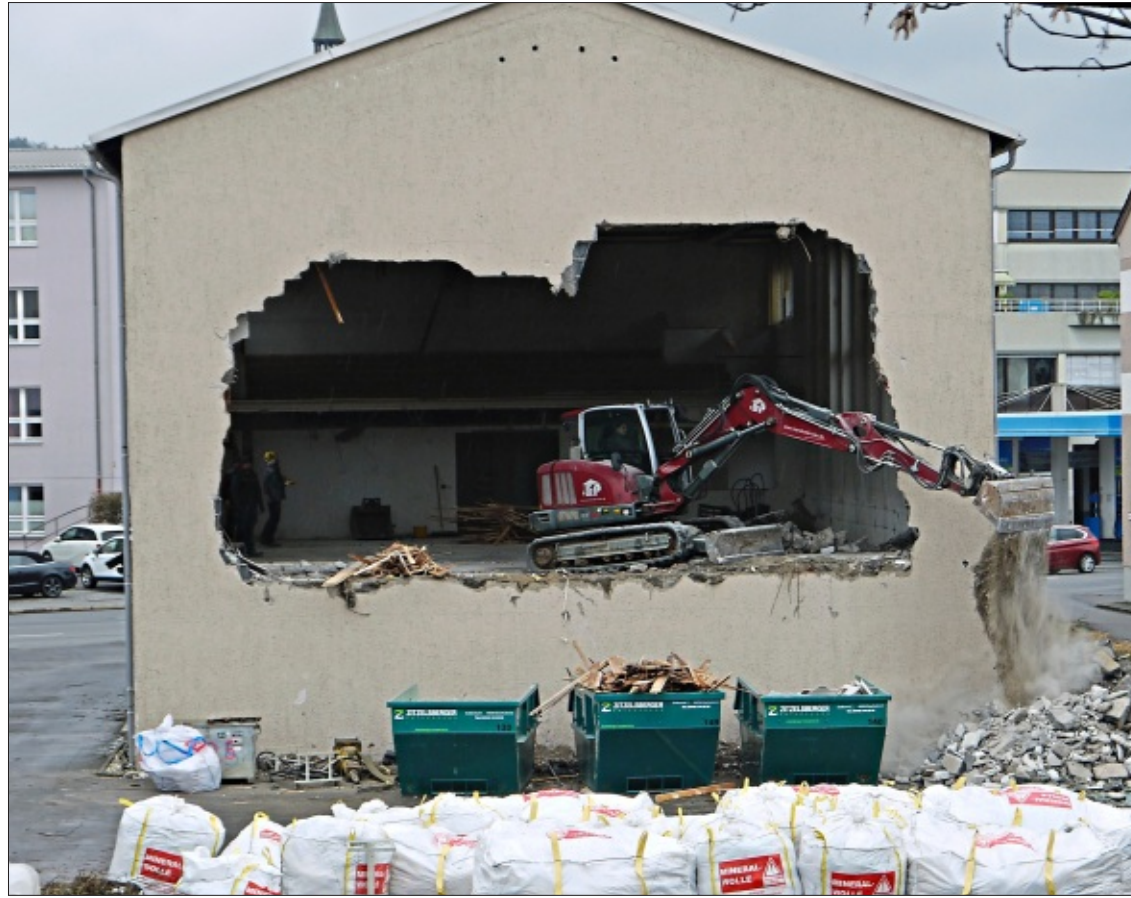
Die Entkernung der ehemaligen neuapostolischen Kirche läuft. Ein Bagger schaufelt Schutt vom einstigen Kirchenraum ins Freie.
